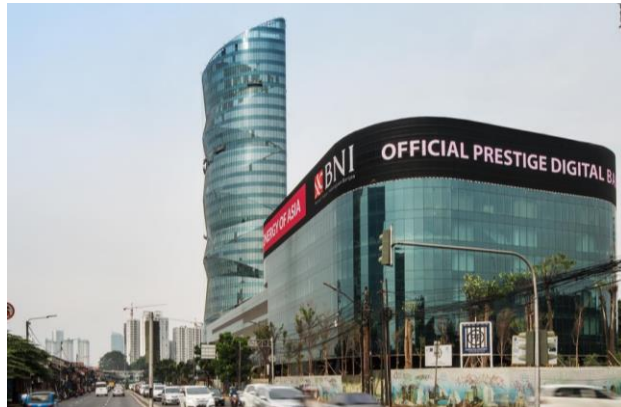
Gambar 3.1 Gedung Menara BNI Pejompongkon
