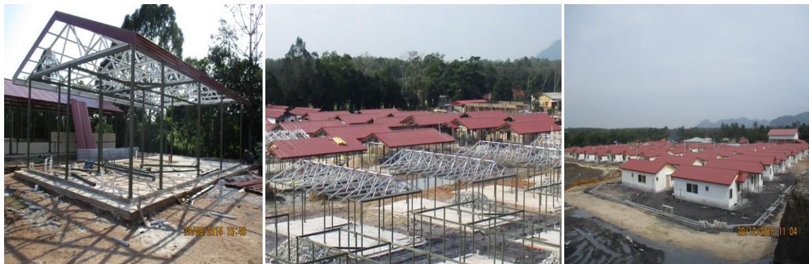
Rajah 2: Pembangunan Projek Perumahan Laman Seri Ehsan Sumber: Pertubuhan Ground Zero
